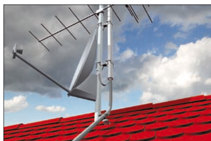
Obr. 4. Přizemnění na ekvipotenciální pospojování domku
