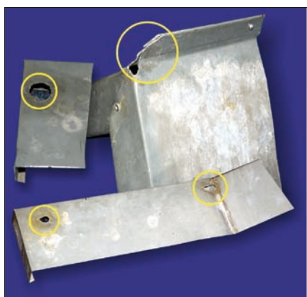
Obr. 1. Propálení plechu z důvodu nedostatečné tloušťky
