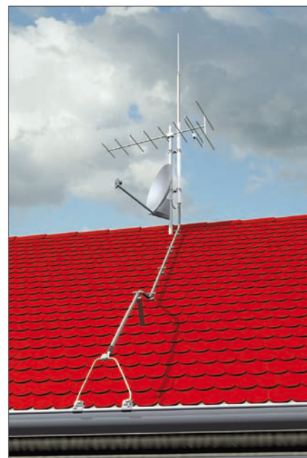
Obr. 3. Příklad systému pro ochranu anténního stožáru
