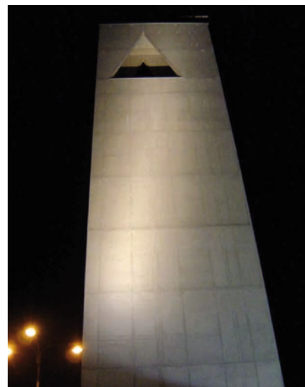
Obr. 4. Zkouška nasvětlení věže z vnější strany ukázala, že idea prosvětlení otvoru zvonice je správná (osvětlení věže z venkovní strany by bylo nevýrazné)
