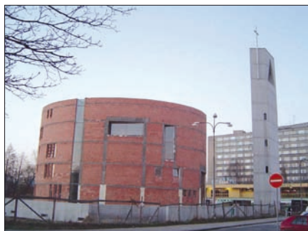
Obr. 2. V době zkoušky nasvětlení byla budova bez fasády
