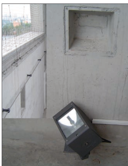
Obr. 7. Prostor zvonů je osvětlen světlomety Thorn Qba1 SYM HIT-DE 70 W, umístěnými v prostoru zvonice u podlahy ve dvou protilehlých rozích
