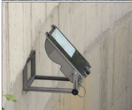
Obr. 5. Obvodové stěny kostela osvětlují světlomety Thorn Sonpak 25/40 Asym HIT 250 W, umístěné na vnější stěně anglického dvorku na konzolách upevněných 0,5 m pod spodním okrajem květníků
