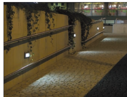
Obr. 8. Přístupy na plato kostela osvětlují vestavná Svítidla Thorn Jalon HG TC-D 26W (horizontální), zabudovaná do svislých opěrných zídek
