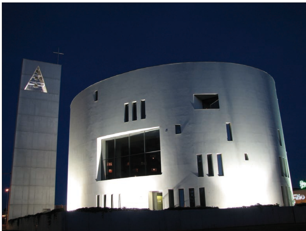
Obr. 9. Výsledné architekturní osvětlení nového kostela Ducha svatého v Ostravě
