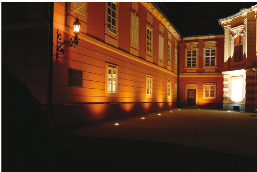
Obr. 3. Umístění svítidel Cricket 26 u paty stěny levého křídla zámku
