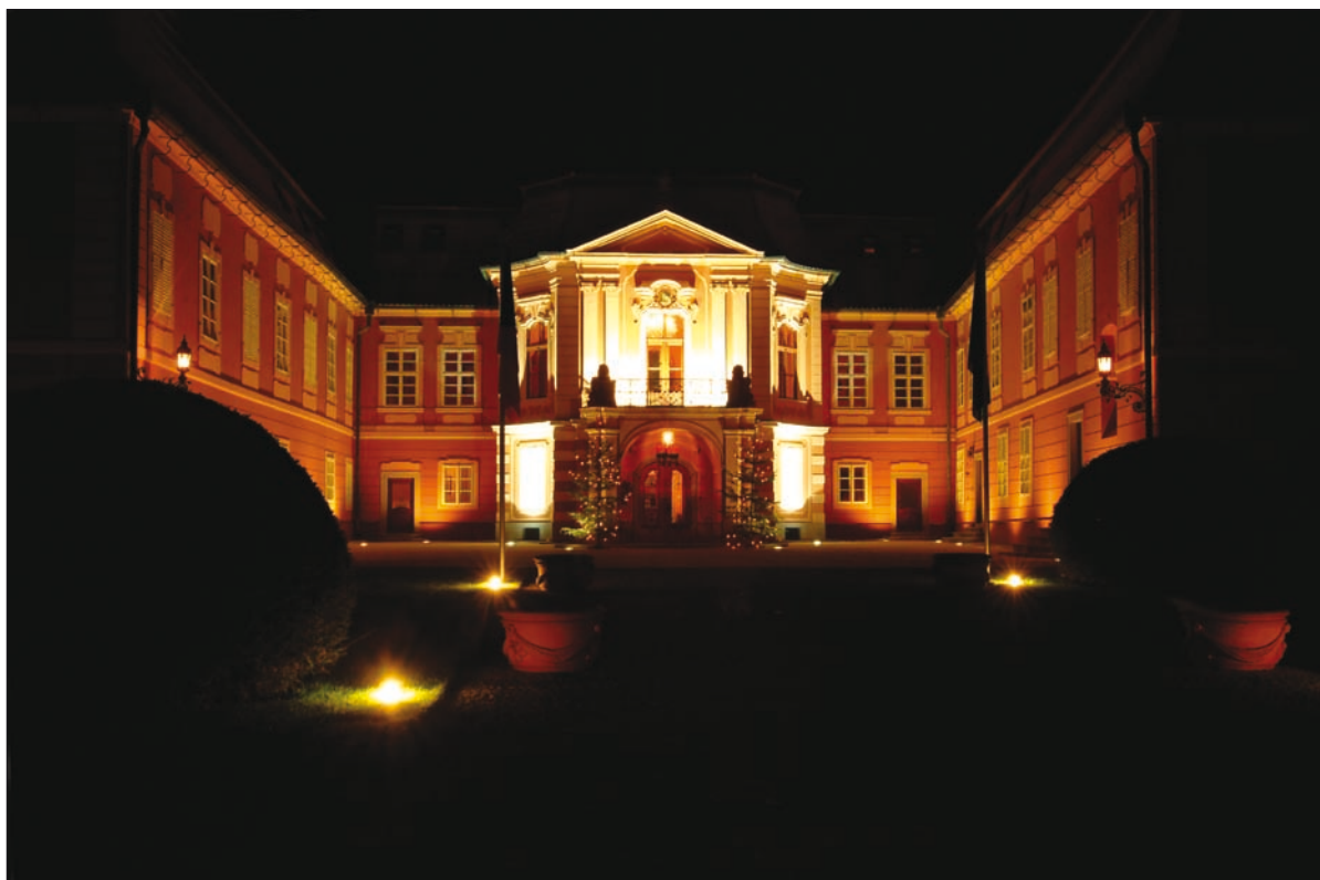
Obr. 2. Pohled na průčelí zámku od vstupní brány; v dlažbě jsou instalována zemní svítidla Cricket 26
