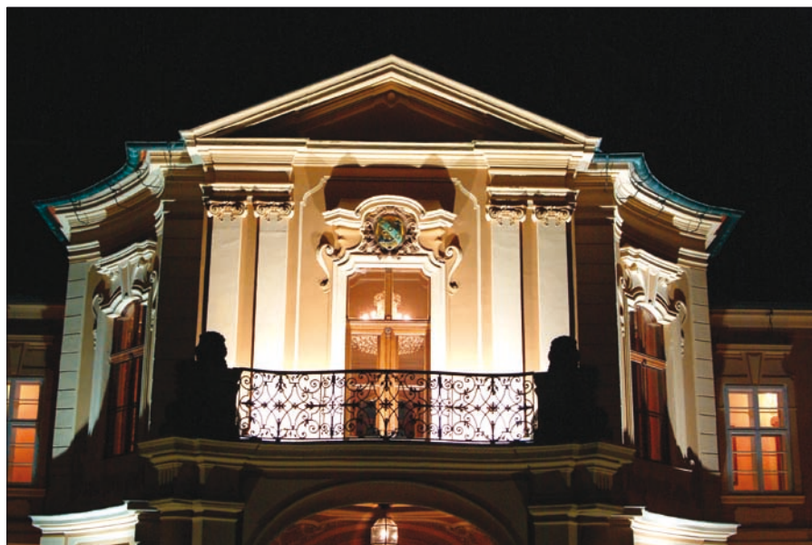
Obr. 4. Vstupní portál je v horní části přisvětlen dvojicí světlometů Ypsilon, ukrytou v zábradlí
