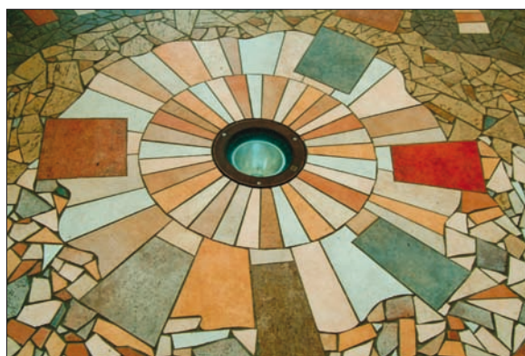
Obr. 6. Jedno ze zemních svítidel Cricket 26 je vestavěno do speciálně navržené mozaiky ve vstupním vestibulu
