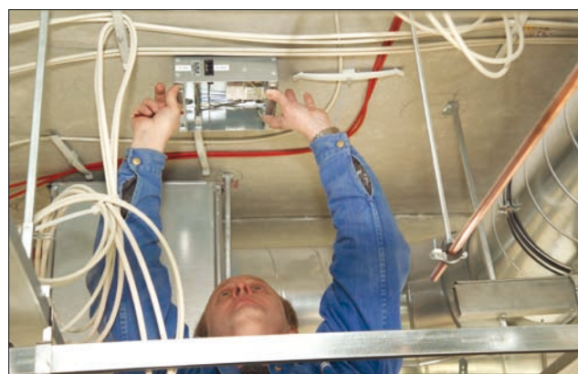
Obr. 2. Montáž svítidla s konektory WINSTA®
