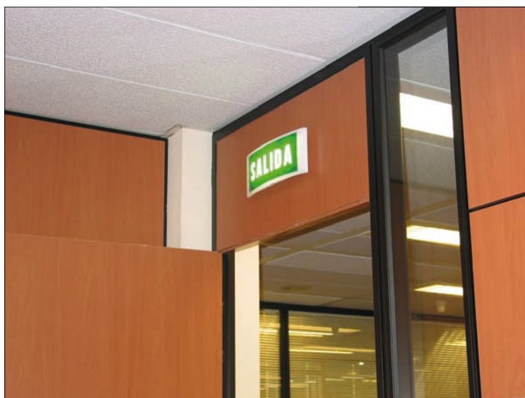
Obr. 8. Nouzové svítidlo řady G5 - nástěnná montáž s piktogramem
