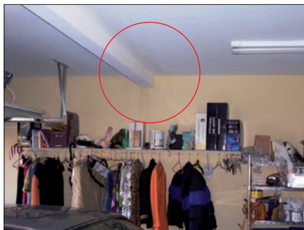
Obr. 2. Garáž s průnikem vlhkosti (vyznačené místo)
