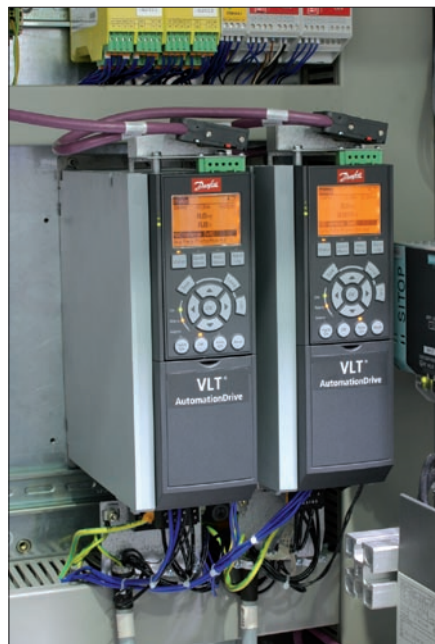
Obr. 3. Modulové měniče frekvence Danfoss VLT® AutomationDrive regulují otáčky pohonu cívky
