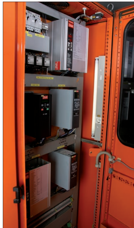
Obr. 4. I přes rozdílný věk zde vedle sebe spolehlivě pracují tři generace měničů frekvence firmy Danfoss – několik rozšíření zařízení vedlo během let k použití různých konstrukčních řad
