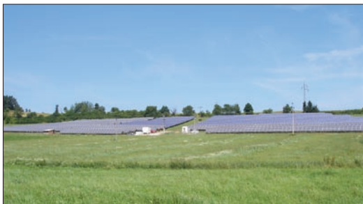
Obr. 1. Fotovoltaická elektrárna Bušanovice
