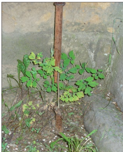
Obr. 2. Ochranná trubka z oceli, co nechrání (měla být na obou koncích utěsněna olovem)
