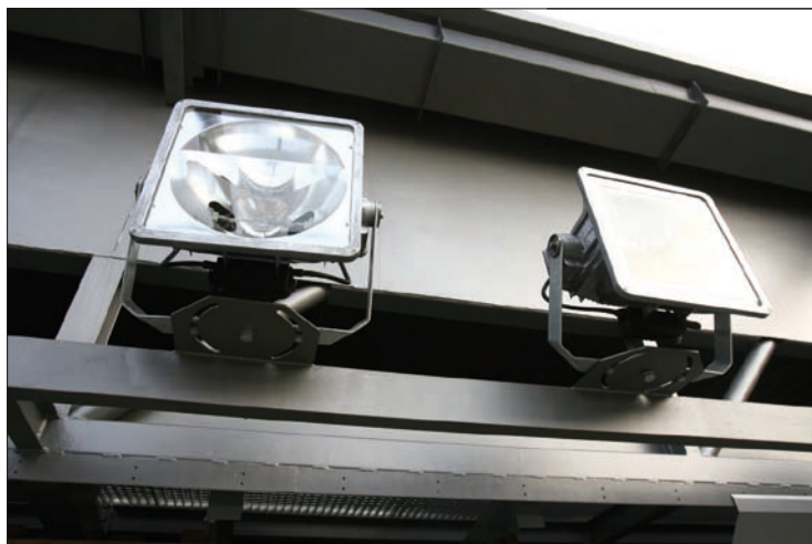
Obr. 3. Svítidla Mundial na rampě stadionu SK Slavia Praha
