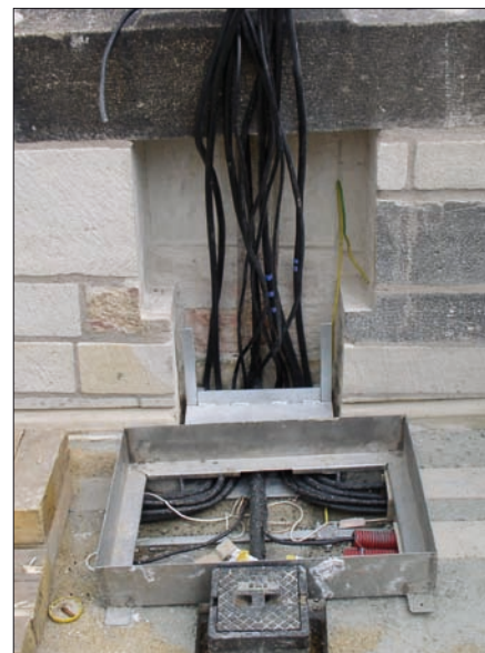
Obr. 4. Nika v zábradlí mostu pro osazení rozvodných skříněk
