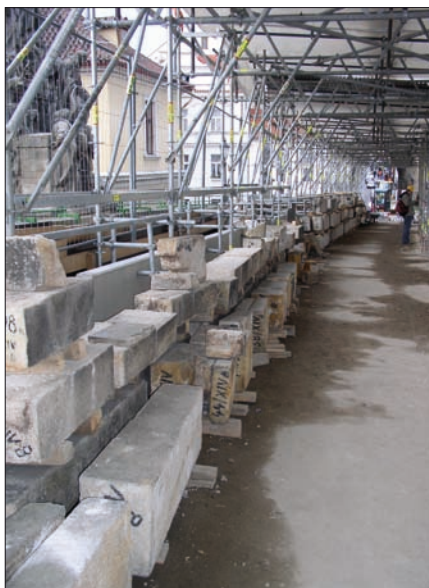
Obr. 2. Rekonstrukce Karlova mostu probíhá po etapách za plného provozu
