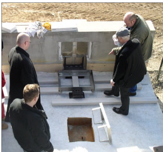
Obr. 3. Pro přípravné práce byla vytvořena maketa části mostu v měřítku 1 : 1
