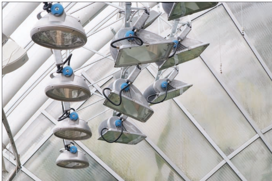
Obr. 4. Osvětlovací soustava z pohledu od vstupních dveří (detail) – tři řady svítidel (zleva Philips MVF 401 s výbojkami MHN-LA 1000 W/956, Philips MVP 507-WB s výbojkami MHN-LA 2000 W/956, Philips MVP 507-MB s výbojkami MHN-La 2000 W/956)
