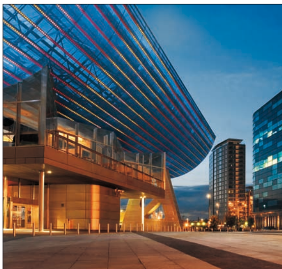
Obr. 1. Osvětlení fasády stadionu svítidly LED Coinlight Cluster
