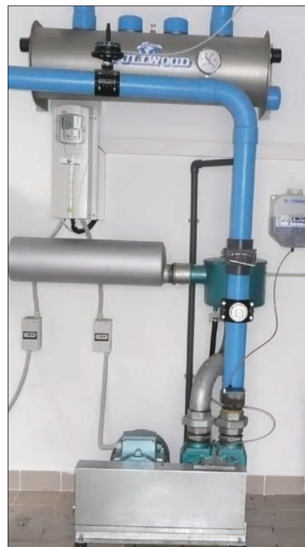
Obr. 3. Systém Fullspeed s měniči frekvence ABB
