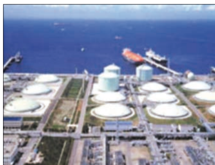
Obr. 4. Palivové nádrže tepelné elektrárny Sodegaura
