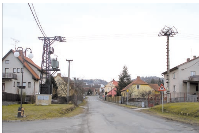
Obr. 3. Rozvod elektřiny v obci
