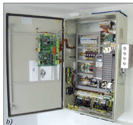
Obr. 9. Ukázka reverzačních stykačů ve výtahovém rozváděči a) ze 70. až 80. let minulého století, b) současné provedení s měničem frekvence
