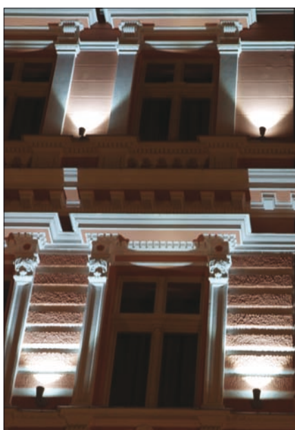
Obr. 4. Detail umístění světlometů Tyco 10/LED a nasvícení říms
