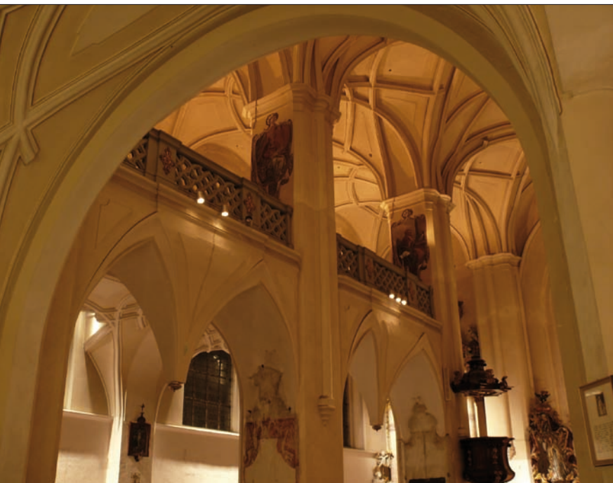
Obr. 4. Některé části chrámového prostoru jsou zdůrazněny směrovým osvětlením; směrová svítidla Tecnica pro osvětlení prostoru lavic jsou umístěna v tříokruhové napájecí liště připevněné na římsě zábradlí na ochozu
