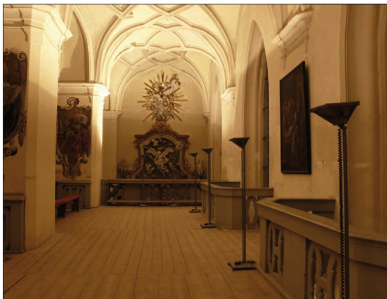
Obr. 3. Osvětlení kleneb kostela stojanovými svítidly Lingotto
