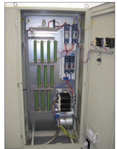
Obr. 9. Měnič Semikron a odporníky realizující rezistor R_p s odpojovací
