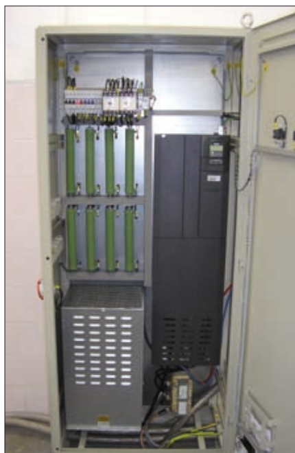
Obr. 10. Měnič Micromaster s brzdným odpor-níkem a nabíjecími rezistory
