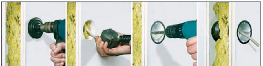
Obr. 9. Jednoduchá montáž systému HWD 90
