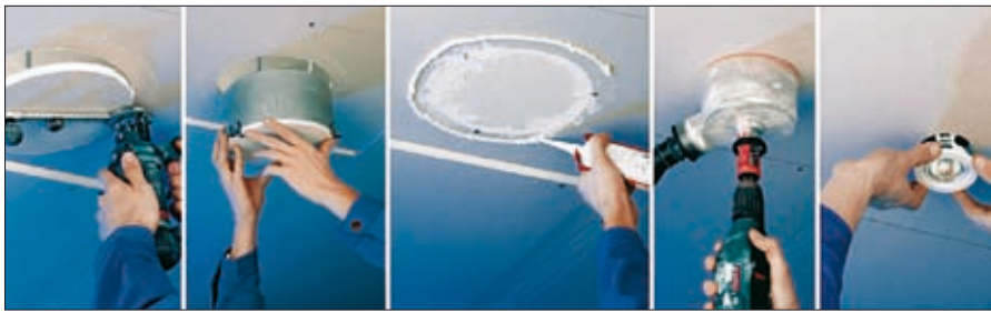
Obr. 1. Montáž krytu FlamoX-S30 H do stropů s dvouvrstvým obložením
