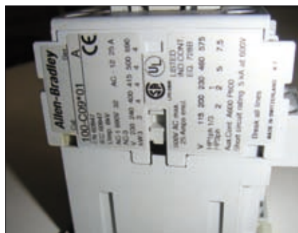
Obr. 1. Pohled na poškozený stykač
