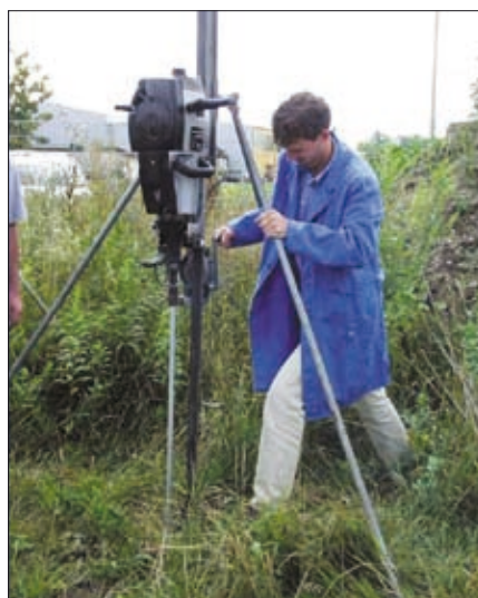
Obr. 14. Trojnožka pro zatloukání hloubkových zemničů
