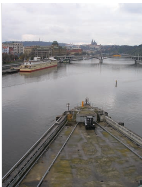
Obr. 4. Z vyhlídkové věže elektrárny na Štvanici se otevírá nezvyklé pražské panorama
