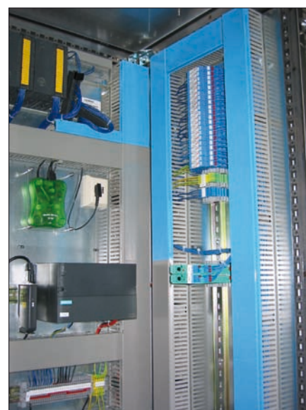
Obr. 5. Instalace svodičů pro jiskrově bezpečné obvody
