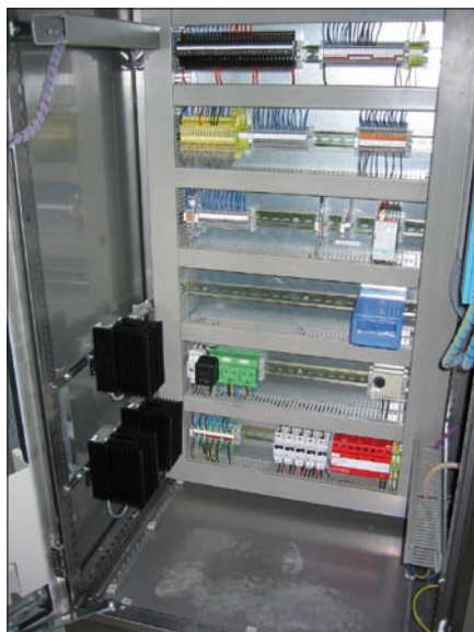
Obr. 4. Kombinovaný svodič DEHNventil TT
