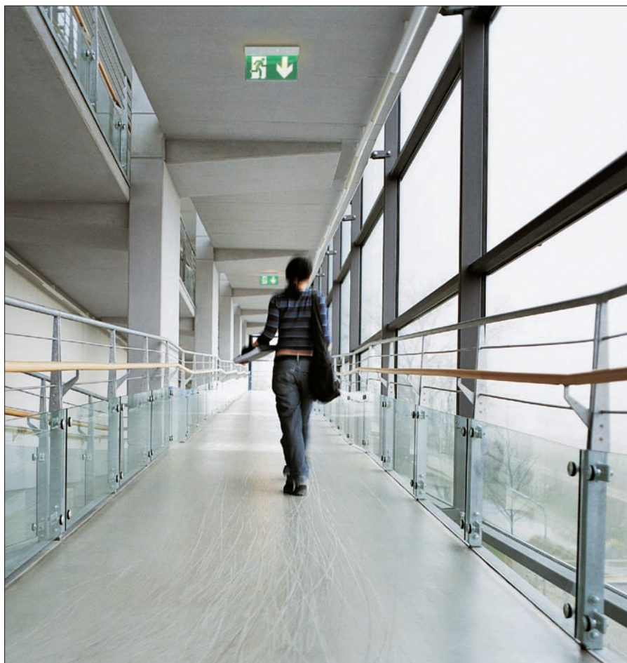
Obr. 3. Nouzové svítidlo BAES plafond na chodbě v zázemí komerční budovy
