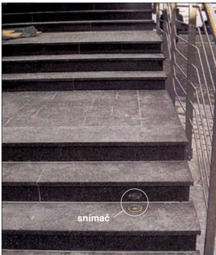
Obr. 1. Schody s kamennými deskami jako obklad je třeba spolehlivě chránit před sněhem a ledem
