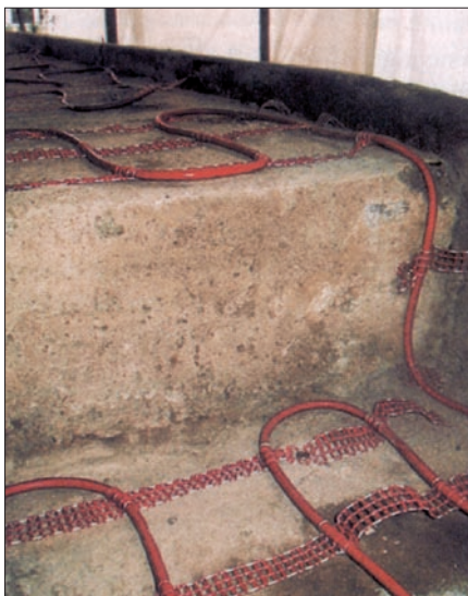
Obr. 2. Pokládání topné rohože
