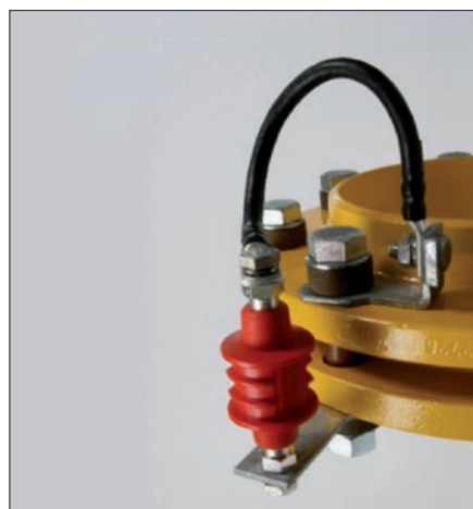
Obr. 1. Jiskřiště v provedení Ex
