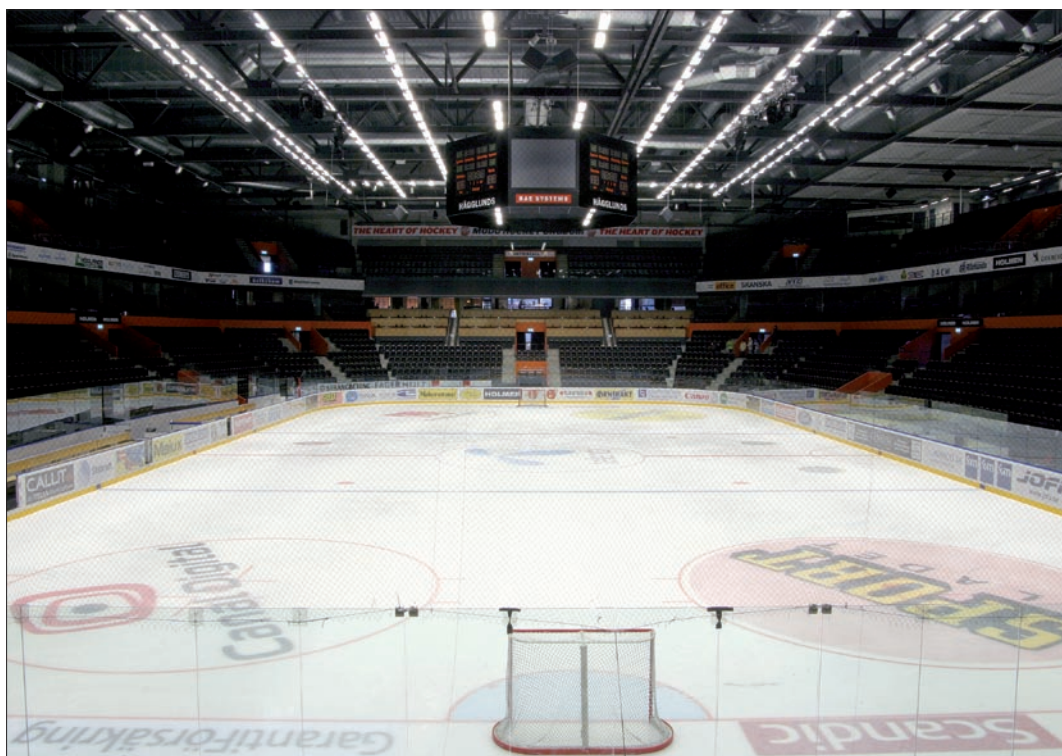
Obr. 3. Osvětlení ledové plochy svítidly Induline
