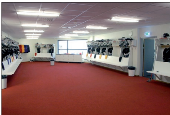
Obr. 5. Osvětlení šaten svítidly Allfive T5
