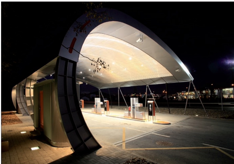
Obr. 7. V popředí zemní svítidla Light Up, iGuzzini, čtvercová, 42 W, kompaktní zářivka 4 000 K (pol. 5), na nejvyšší části zastřešení podhledová svítidla Pixel Plus střední, iGuzzini, 70 W, 3 000 K
