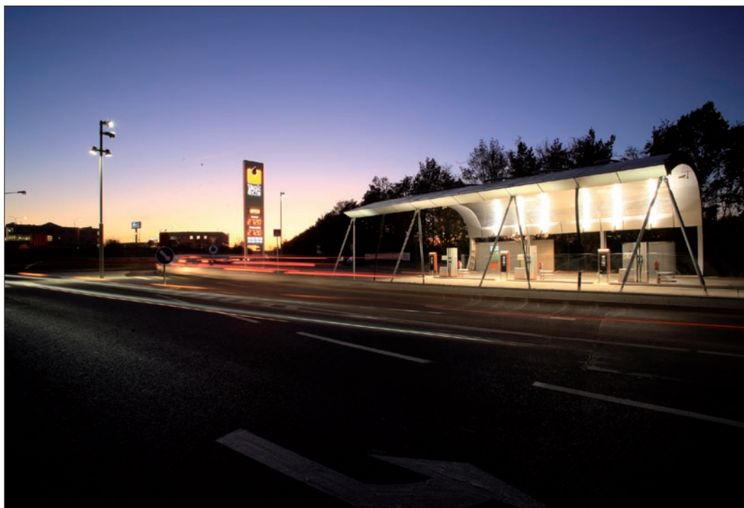
Obr. 4. Celkový pohled s totemem, se sloupem veřejného osvětlení (VO4) se sdruženými svítidly – dva světlomety Multiwoody, iGuzzini 150 W spot pro přechod pro chodce, dva světlomety Multiwoody, iGuzzini 150 W spot opatřeny Fresnelovými čočkami a clonami pro nasvětlení zastřešení
