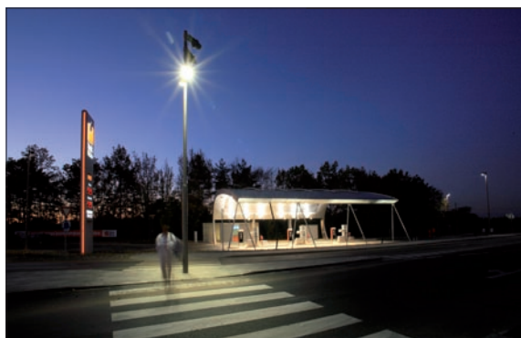
Obr. 5. V popředí sloup veřejného osvětlení systému Multiwoody VO4 (včetně stožáru) s osvětlením přechodu pro chodce a celkového vnějšího osvětlení zastřešení čerpací stanice, vpravo vedle zastřešení stožáry veřejného osvětlení Multiwoody street, iGuzzini VO2, VO3, všechna svítidla osazena halogenidovými výbojkami 150 W, 4 000 K
