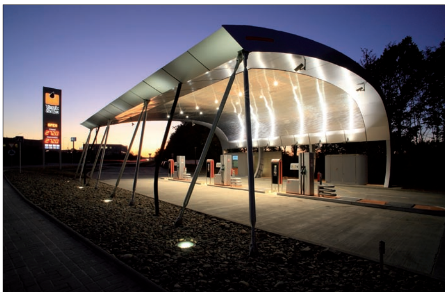
Obr. 6. V popředí zemní svítidlo pro podsvícení atiky Light Up (iGuzzini) 70 W, 4 000 K, kruhové (pol. 4) + Fresnelova čočka pro roztažení světelného svazku na osvětlovaný objekt
