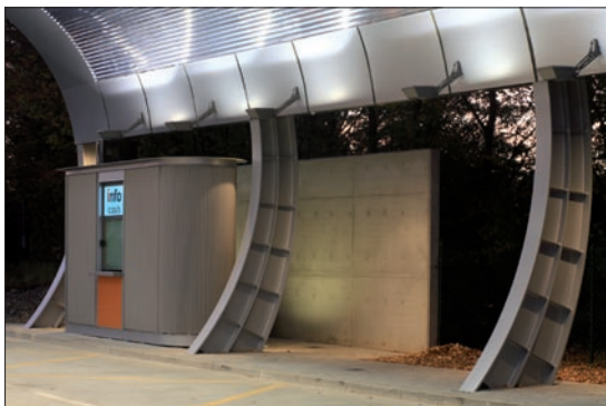
Obr. 8. Detail nepřímého hlavního osvětlení svítidla Platea, iGuzzini (pol. 1), 250 W, 4 000 K, teplé světlo dáváji podhledová svítidla Pixel Plus, iGuzzini (pol. 3), 70 W, 3 000 K
