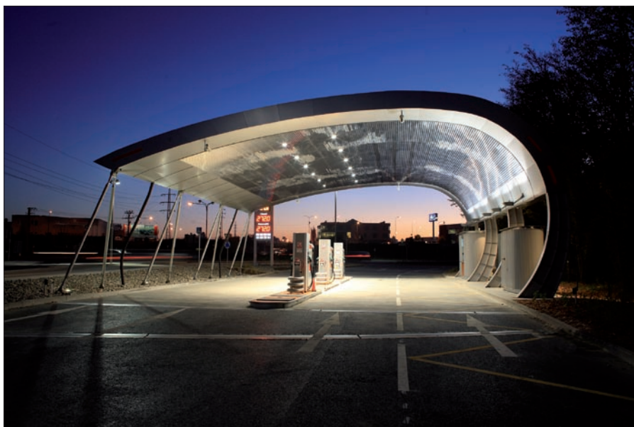
Obr. 9. Boční pohled – v podhledu zastřešení jsou podhledová výklopná svítidla Pixel Plus velká, iGuzzini, 150 W, 4 000 K (pol. 2), vpravo jsou na konzolách svítidla Platea, iGuzzini (pol. 1), 250 W, 4 000 K, zcela vpravo na konci zastřešení pohledová svítidla Pixel Plus střední, iGuzzini, 70 W, 3 000 K, zcela vlevo zemní svítidla Light Up, iGuzzini (pol. 4), 70 W, 4 000 K
