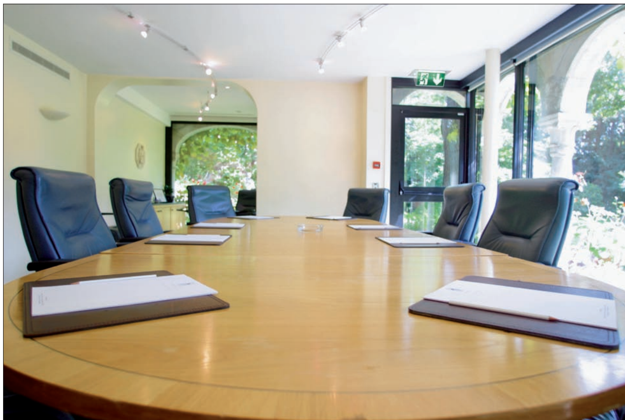
Obr. 2. Nouzové svítidlo BAES plafond v zasedací místnosti
