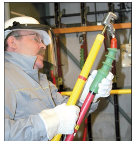
Obr. 2. Příprava na vložení kabelu
