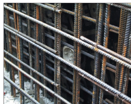
Obr. 2. Víčko KBV připevněné na bednění
