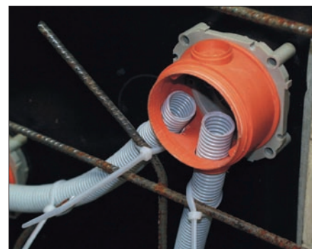
Obr. 3. Ohebné trubky namontované do tělesa KBT
