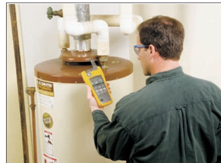
Obr. 3. Měření koncentrace oxidů uhlíku v okolí kotle
