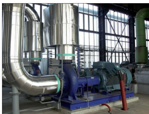
Obr. 4. ...Stav po rekonstrukci
