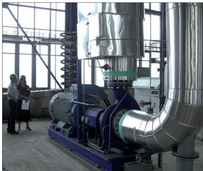
Obr. 6. ...Stav po rekonstrukci
