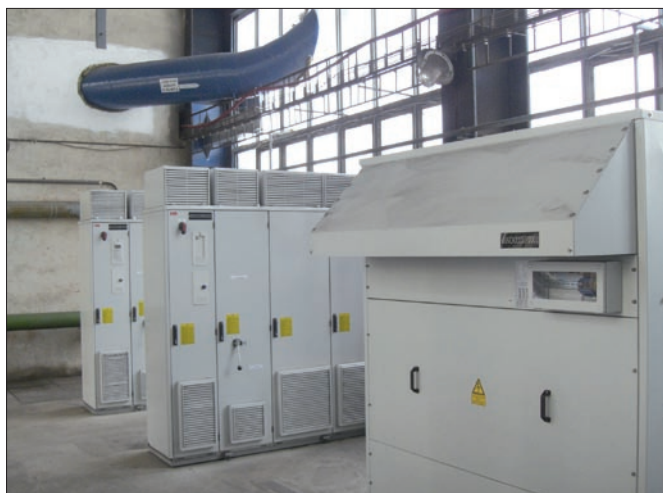
Obr. 5. Měníče ACS 800 (v pozadí) jsou ve skříňovém provedení a v krytí IP54; standardním vybavením měničů jsou vstupní střídavé tlumivky, filtr RFI-EMC; měniče řady ACS umožňují použít další volitelné příslušenství; v popředí vpravo jsou transformátory Resibloc
