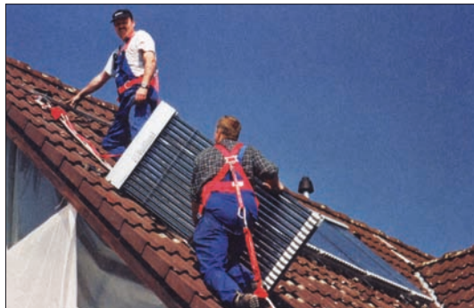
Obr. 1. Instalace solárních panelů pro regenerační podporu vytápění
