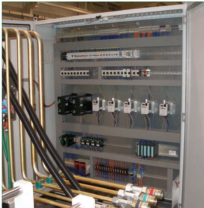
Obr. 4. Rozváděčová skříň s komponentami Murrelektronik
