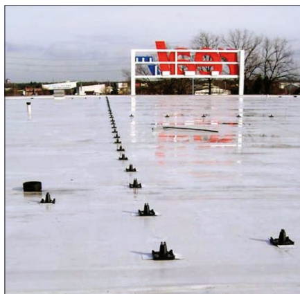
Obr. 5. Nalepené podpěry
