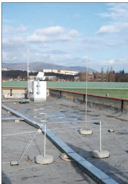
Obr. 10. Jímací vedení uložené na distančních vzpěrách (pod ním vede kabelová trasa, která není připojena k jímací soustavě)
