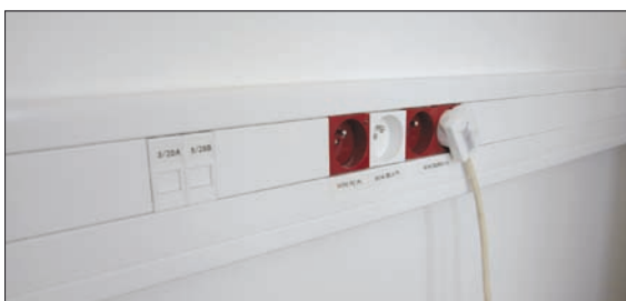
Obr. 2. Příklad montáže PK 120 × 55 D
