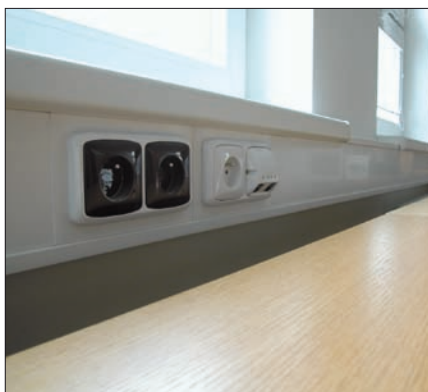
Obr. 6. Prostřednictvím krabic lze do jednodemorových kanálů zabudovat přístroje
