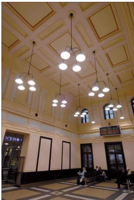
Obr. 5. Svítidla Oculus na čtyřramenných závěsech
