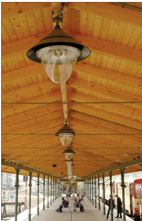
Obr. 3. Na nástupištích, která bezprostředně navazují na historickou budovu, jsou pod dřevěnou střešní konstrukcí zavěšena svítidla Decostyle
