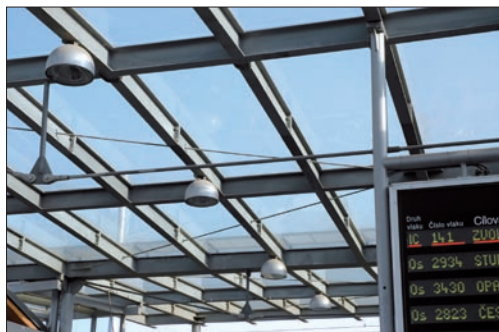
Obr. 2. Svítidla Victor zavěšená na kovové konstrukci
