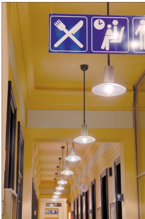
Obr. 6. Svítidla Oculus na trubkových závěsech
