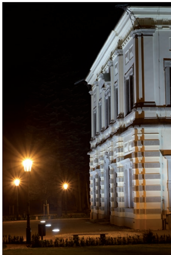
Obr. 4. Vstupní průčelí letohrádku nasvícené zemními svítidly Cricket 40
