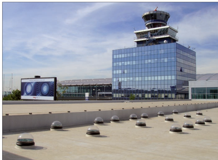
Obr. 2. Světlovody použité pro osvětlení Terminálu Sever Letiště Ruzyně (foto: Bitumen & Plastic, s. r. o., český výrobce světlovodů Lightway)
