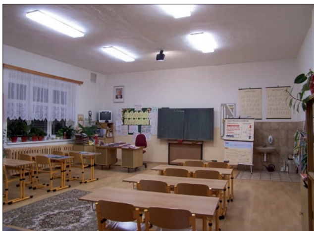
Obr. 1. Stará osvětlovací soustava - nevhodné rozmístění stolů
