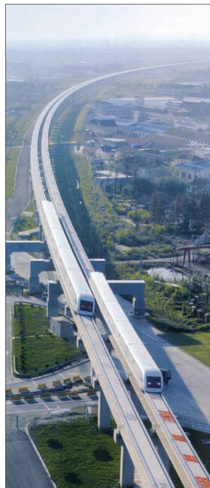
Obr. 13. Dvouproudová jízdní dráha SML
