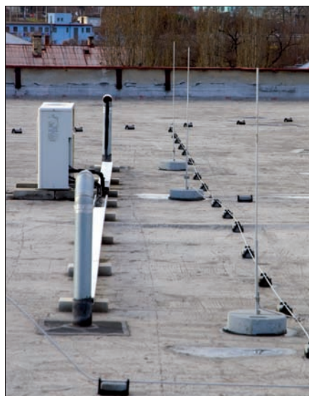
Obr. 8. Sestava jímacích tyčí chrání klimatizační jednotku
