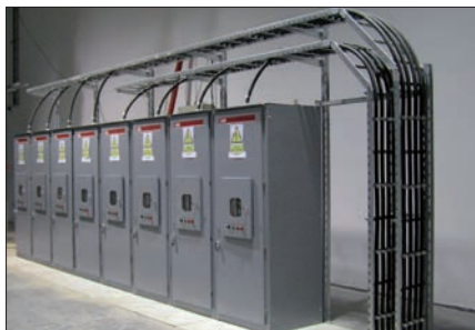
Příklad instalace osmi kusů softstartérů SSM
