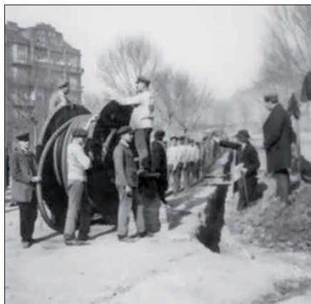
Obr. 1. Pokládka distribučního kabelu (20. léta dvacátého století)
