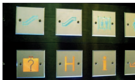
Obr. 7. Orientační a informační světelné prvky velikosti vypínače – pod krytem jsou tři diody LED
